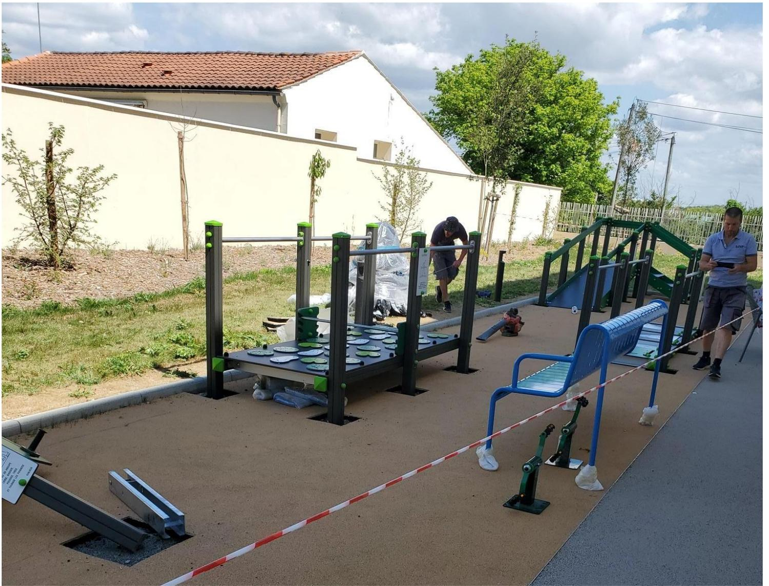
Selon la nature du sol la fixation peut être à sceller au béton avec une finition par un sol souple comme ci-dessus ou une fixation sur platines ou équerres.
